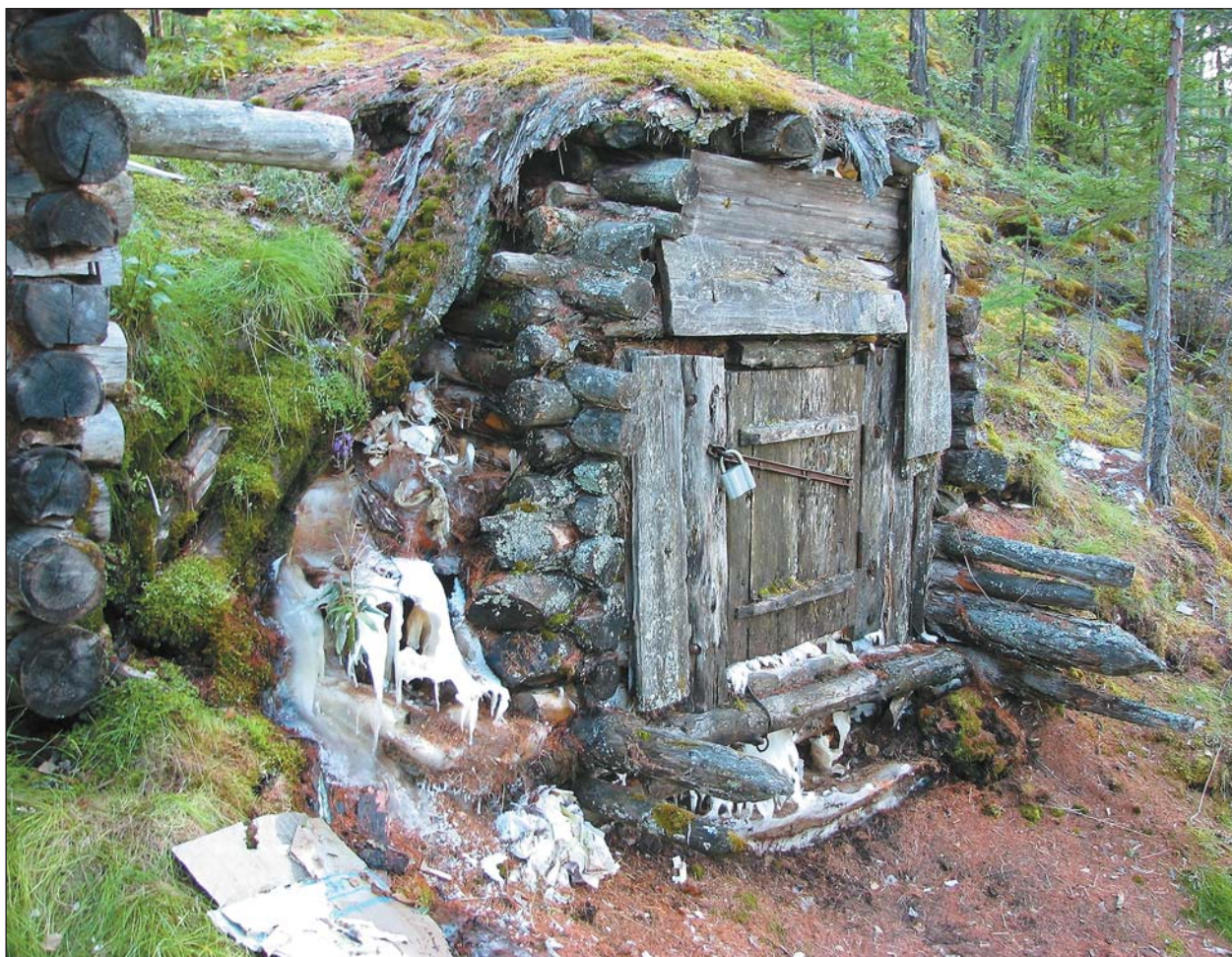
Более чем 100-летний амбар для хранения мяса (Якутия). За счет эффекта вечной мерзлоты оно сохраняется даже при наружной температуре +35^{\circ}\text{C} .
